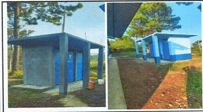
Foto 3: avance cernido interior y exterior para baños y un lado de aula de primero primaria cernido y alisado.
